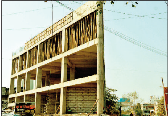
इमलीपारा रोड में निर्माणाधीन काम्प्लेक्स का काम बंद।
