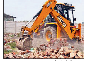
अवैध निर्माण को ढहाती जेसीबी।
