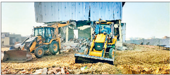
झज्जर। अवैध निर्माण ढहाने में जुटी जेसीबी। फोटो:हरिभूमि
