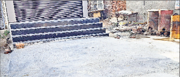
झज्जर। शहर के मेन बाजार में दुकान के बाहर बनाया हुआ अवैध चबूतरा।
