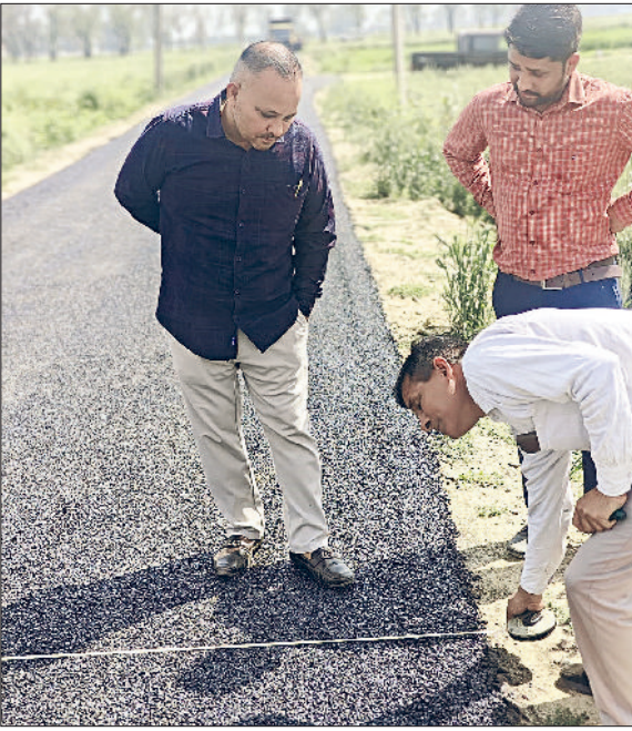
कैथल। बन रही नई सड़क का निरीक्षण करने पहुंचे मार्केटिंग बोर्ड के कार्यकारी अभियंता सतपाल गोपेरा।
