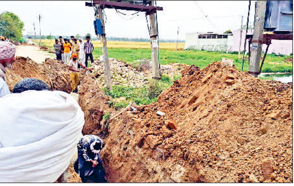
गांव तलवाड़ी में एसटीपी को लेकर डाली जा रही पाइप।
