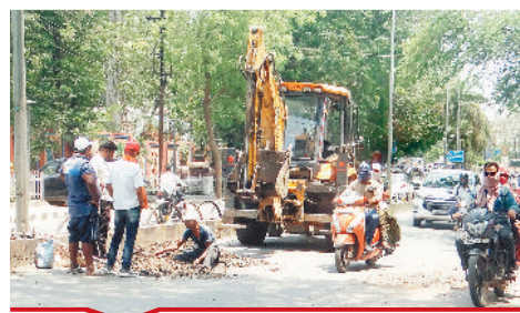
नेहरू चौक से कलेक्टर कार्यालय जाने वाली सड़क पर हो रही खुदाई के कारण लग रहा जाम।
