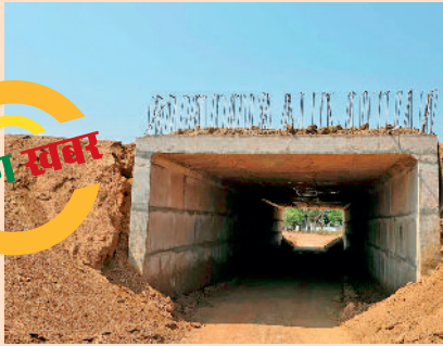
नदी में पुल की लंबाई भी कम: भारतमाला प्रोजेक्ट के तहत चल रहे सड़क निर्माण में शिवनाथ नदी में एक पुल का भी निर्माण किया जा रहा है। पुल का निर्माण सिर्फ दो से फीट तक किए जाने से अब कई गांव बाढ़ की चपेट में आ जाएंगे।
