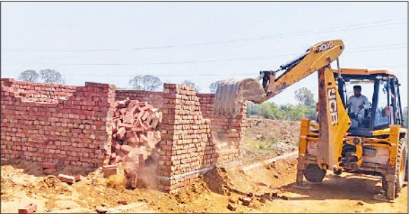
बहादुरगढ़। अवैध कॉलोनी में किए जा रहे निर्माण को ढहाती डीटीपी की जेसीबी।
