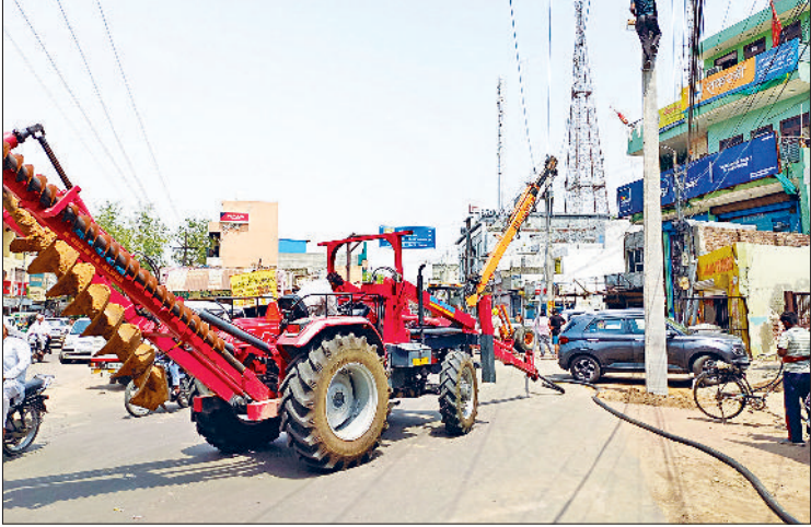
झज्जर। शहर के सिलानी गेट क्षेत्र में बिजली की केबल बदलते हुए कर्मचारी।
