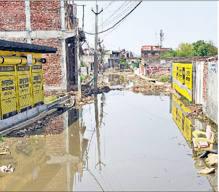
झज्जर। शहर की नीम वाली कॉलोनी की मुख्य सड़क पर भरा बरसाती पानी। फोटो: हरिभूमि
