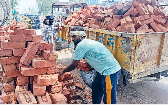
पूंडरी। साइट से निर्माण सामग्री को उठाकर वापस ट्रॉली में डालते मजदूर।
