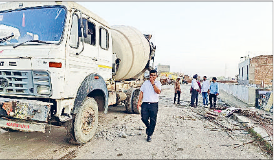
रेवाड़ी। कोसली आरओबी के पुनर्निर्माण कार्य का निरीक्षण करते एसडीएम।
