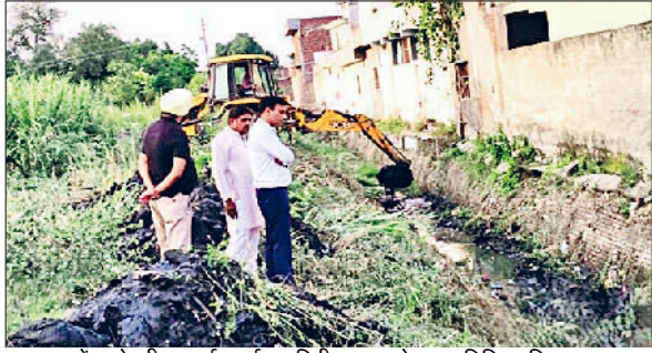
शहर में नाले की सफाई कार्य का निरीक्षण करते हुए अतिरिक्त निगमायुक्त।
