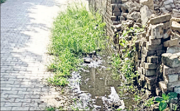
यमुनानगर। गांव अलाहर में सफाई न होने से गंदगी से अटी पड़ी नाली।
